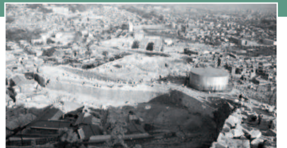
한양도성 보수공사 전(1977)
