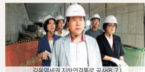
김음역세권 지하연결통로 공사(8. 7.)
