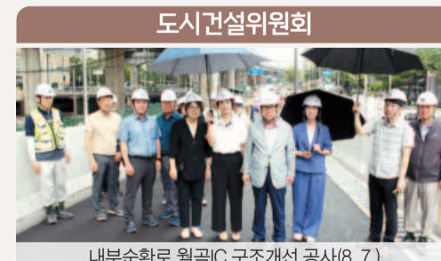
내부순환로 월곡IC 구조개선 공사(8. 7.)
