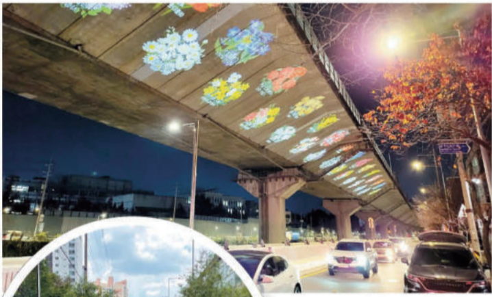
정릉천 하류 야간조명 설치
